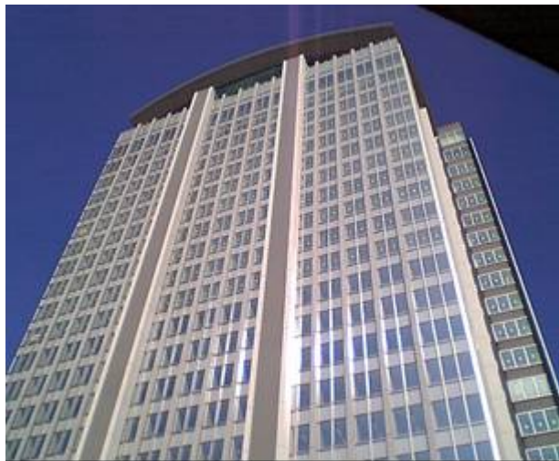
ランドマークとしての新本社ビル
